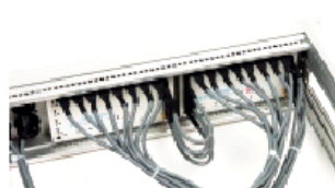
Steckanschlussverkabelung mit Kaskadierung von zwei Moduline-Kreuzschienen
